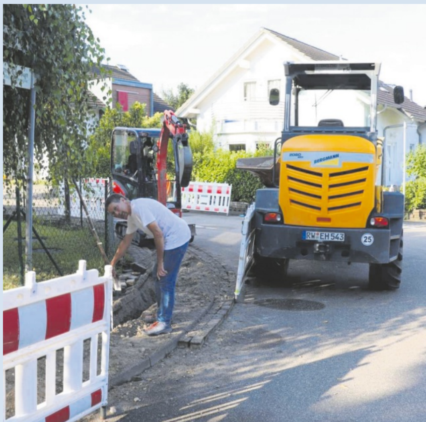
Stephan Huber vom Bauamt bei der Tiefenkontrolle an der Baustelle Montlouisring.
