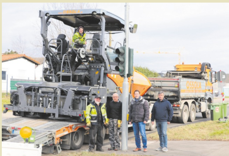
Bürgermeister Manuel Tabor (2.v.r.) und Bauamtsleiter Uli Brudy (r.) mit Mitarbeitern der Firma Ossola an der Baustelle in der Sander Straße
