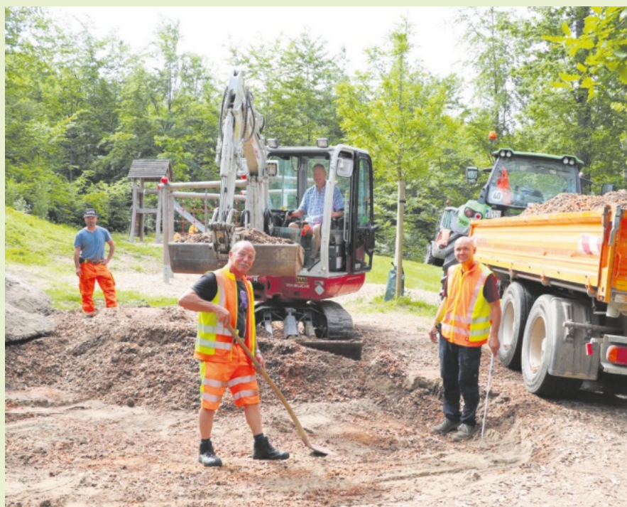
v.l.: Frank Metzler, Klaus Meidinger, Dieter Lerch (im Bagger) und Arnold Haas an der Baustelle für die neue Schaukel am Waldspielplatz
